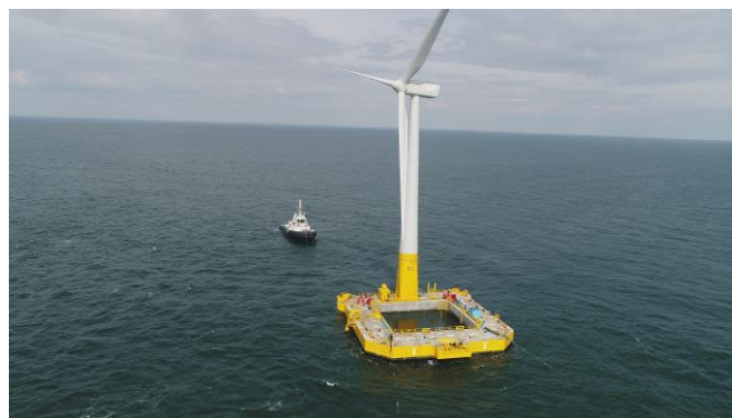
Figure 6 : mise à l'eau de Floatgen, première éolienne flottante de France (opérations et maintenance gérées par QEM)
